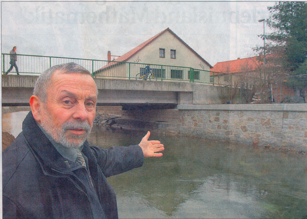
Ganz neu und schön anzusehen sind die Uferbefestigungen an der Müglitz in Dohna an der Brücke Dresdner Straße. Trotzdem ist Bürgermeister Friedhelm Putzke nicht zufrieden: Seiner Meinung nach ist die Mauer am Fluss zu niedrig geraten, Überschwemmungen würden drohen. Foto: Daniel Spittel
